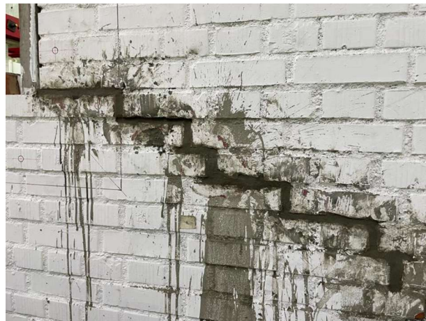
7. 裂縫修復完成
